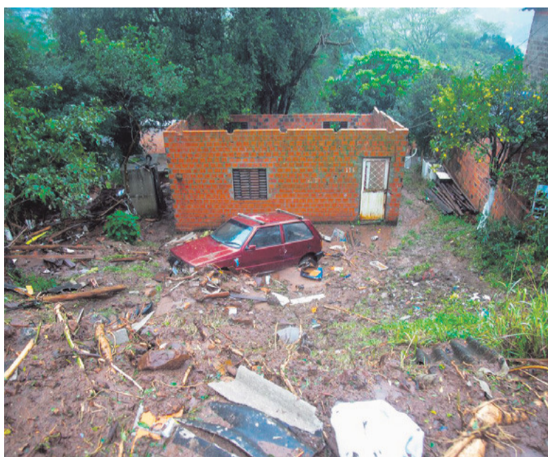
DESTRUIÇÃO No Morro do Cechella, casas estão destruídas. Na tarde de quarta-feira, mãe e filha morreram em deslizamento de terra na região
